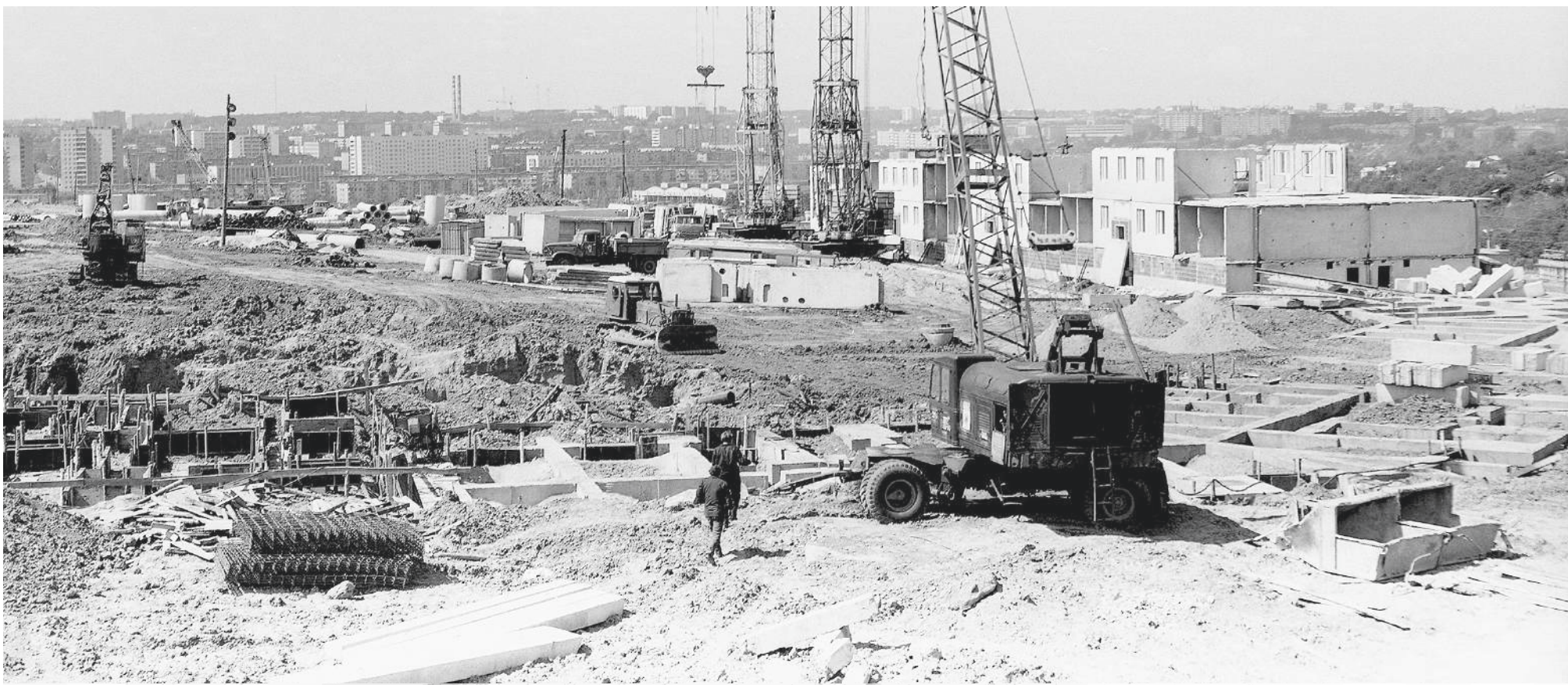
Верхние Печеры. Начало строительства микрорайона. 1980 год
