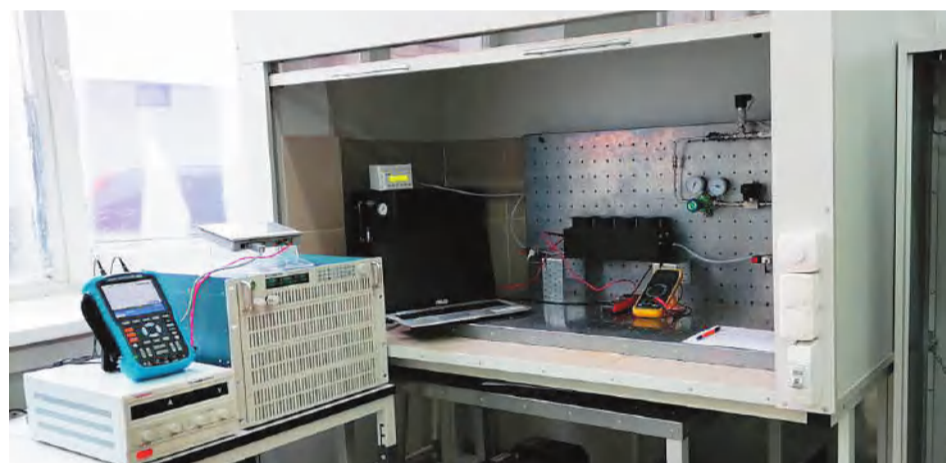
Водородный электроэнергетический комплекс
