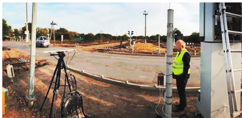
Испытания радара на железнодорожном переезде
