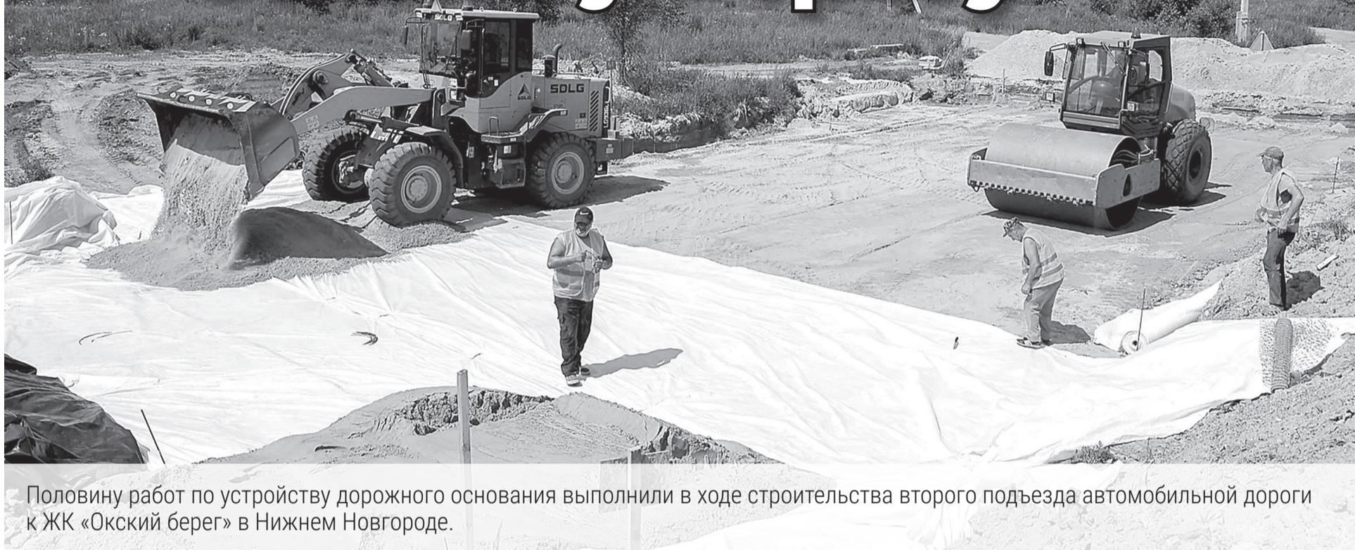
Половину работ по устройству дорожного основания выполнили в ходе строительства второго подъезда автомобильной дороги к ЖК «Окский берег» в Нижнем Новгороде.
