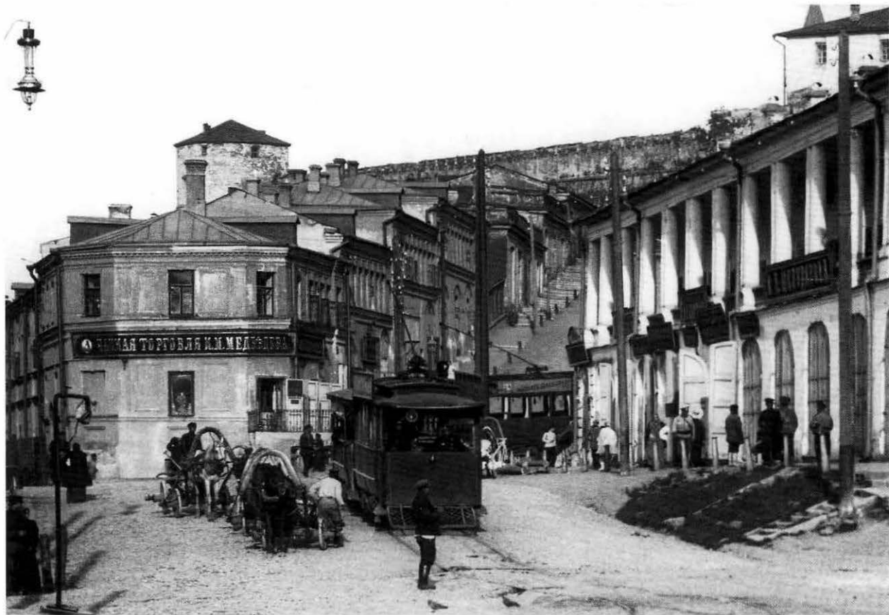
Двухвагонный поезд готов к отправлению от нижней станции фуникулера. Конец XIX века
